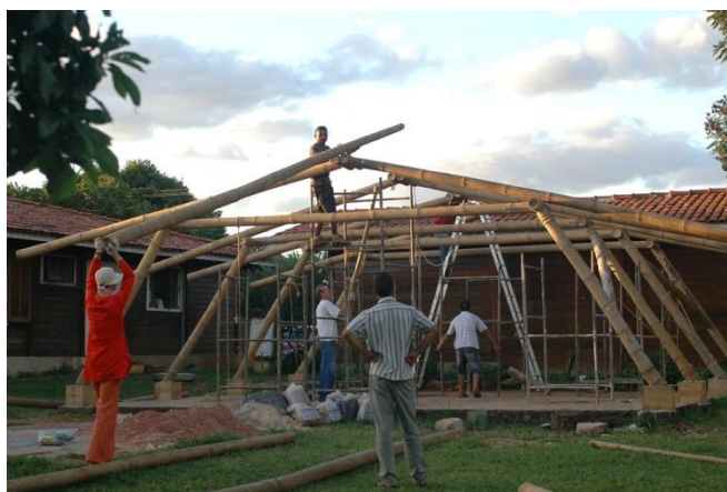
Figura 03: Montagem de uma estrutura durante o curso
