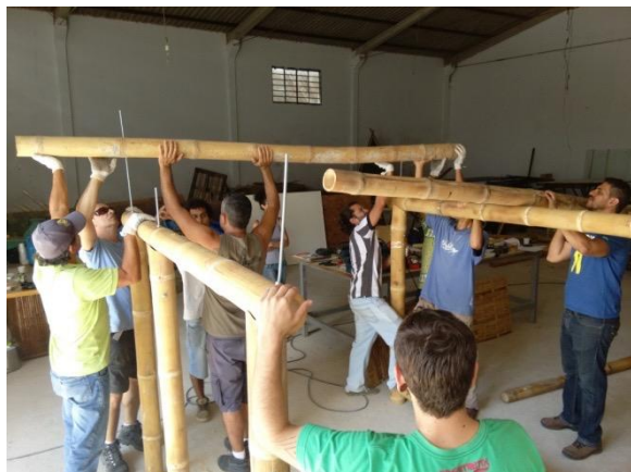
Figura 08 : montagem da estrutura
