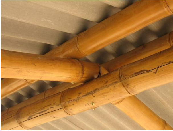
Detalhe da viga de cumeeira
