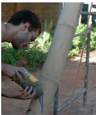
Figura 24 – Preenchimento do pilar com argamassa 1:1
