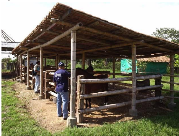
Estrutura para curral
