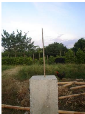
Figura 22 – Ferro chumbado na fundação
