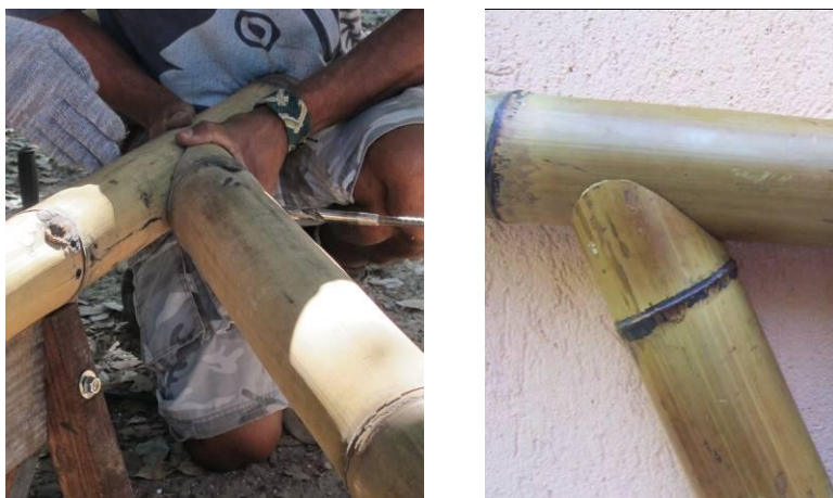
Figura 29 – Encaixe de peça com boca de 45°.
