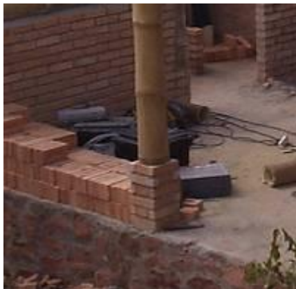
Figura 18 – Apoio pilar de bambu sob tijolos.
