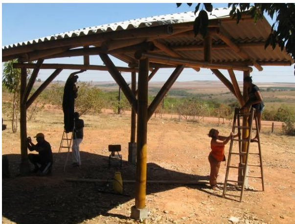
Envernissamento da estrutura
