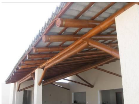
Figura 25 – Corte reto em peças aparentes.
