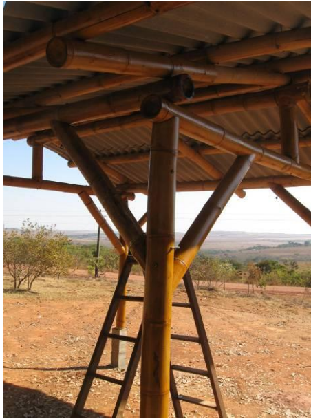
Detalhe da junção das peças
