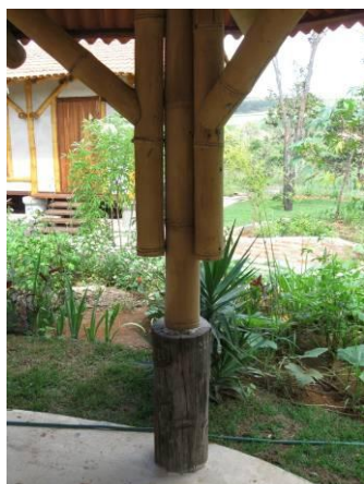
Figura 19 e Figura 20 – Apoio pilar de bambu sob sapatas de concreto.
