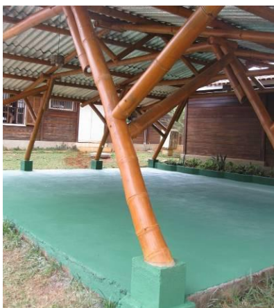
Figura 19 e Figura 20 – Apoio pilar de bambu sob sapatas de concreto.
