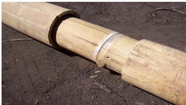
Figura 32 – União com embuchamento interno de bambu.
