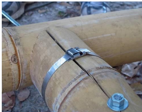
Figura 37 – Braçadeira com fita de arquear.
