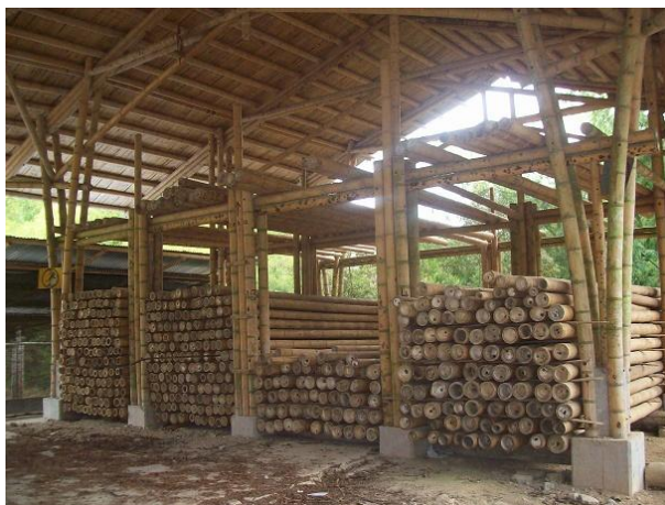
Figura 16 – Armazenamento adequado dos bambus.
