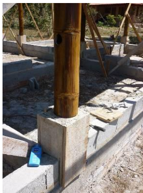
Figura 23 – Fixação pilar-fundação
