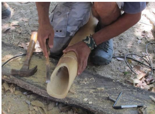
Figura 28 – Corte boca 45°.
