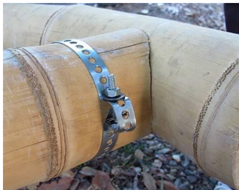
Figura 36 – Braçadeiras de fita perfurada.
