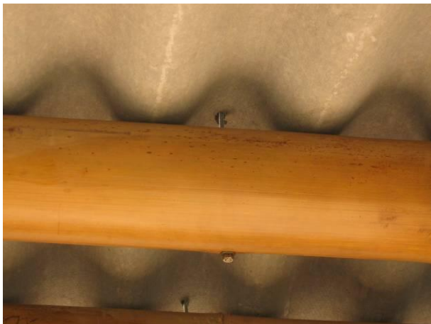
Detalhe da fixação da telha
