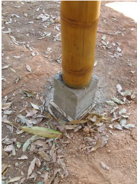
Pilar apoiado sobre pilarete de concreto
