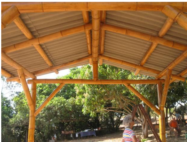
Detalhe da tesoura
