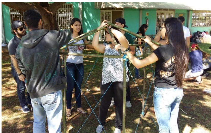
Figura 11 - Grupo executando a estrutura
