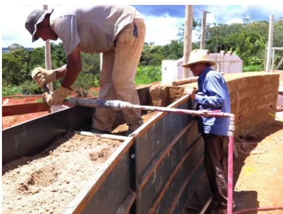
8. Lançamento do solo no interior da forma
