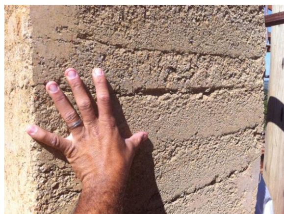
9. Detalhe da espessura da parede
