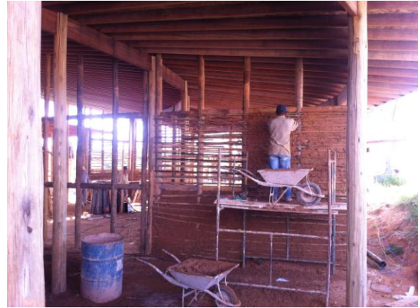
9. Execução da parede de Taipa de mão
