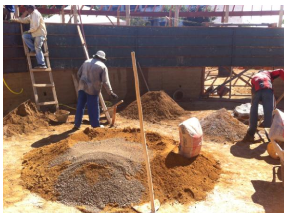
6. Mistura do solo para a execução da taipa
