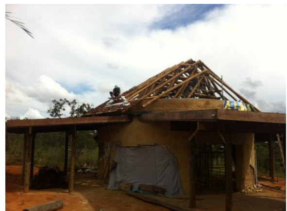
Figura 14: vista do Prédio Multiuso durante a obra
