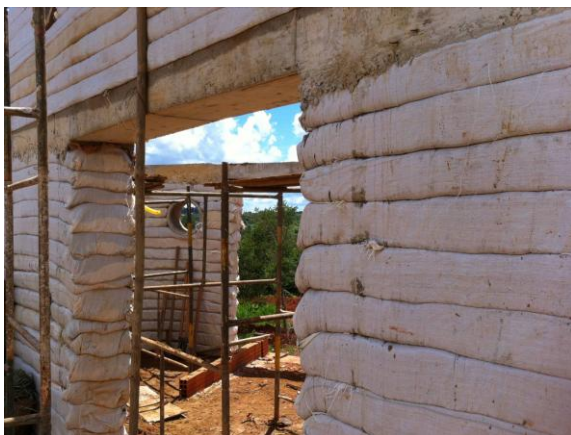
Figura 15: Detalhe do superadobe
