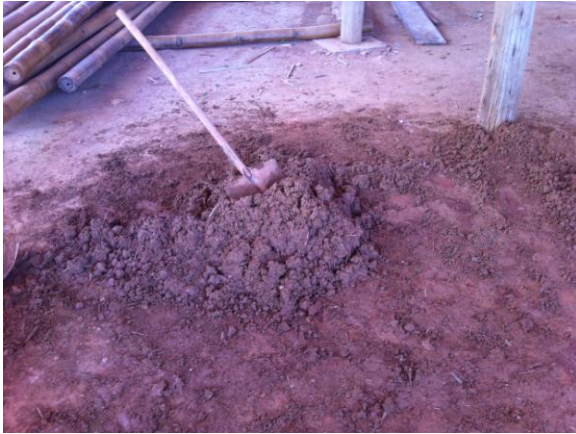
8. Mistura solo para as paredes de Taipa de mão
