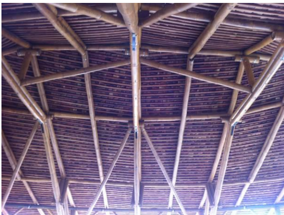
Figura 22: Detalhe da cobertura da Oca
