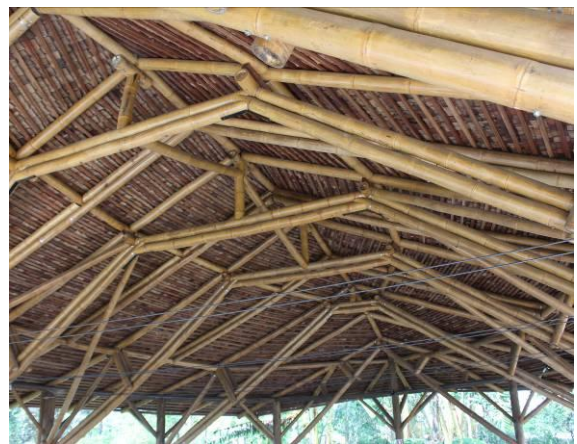
Figura 23: Detalhe da cobertura da Oca
