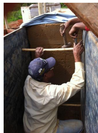
7. Instalação da forma metálica
