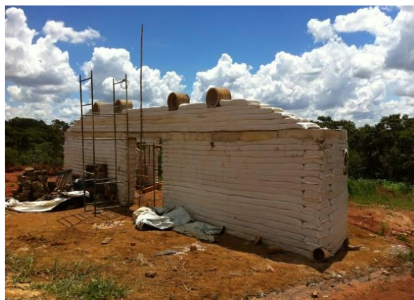
Figura 19: Execução das paredes de superadobe
