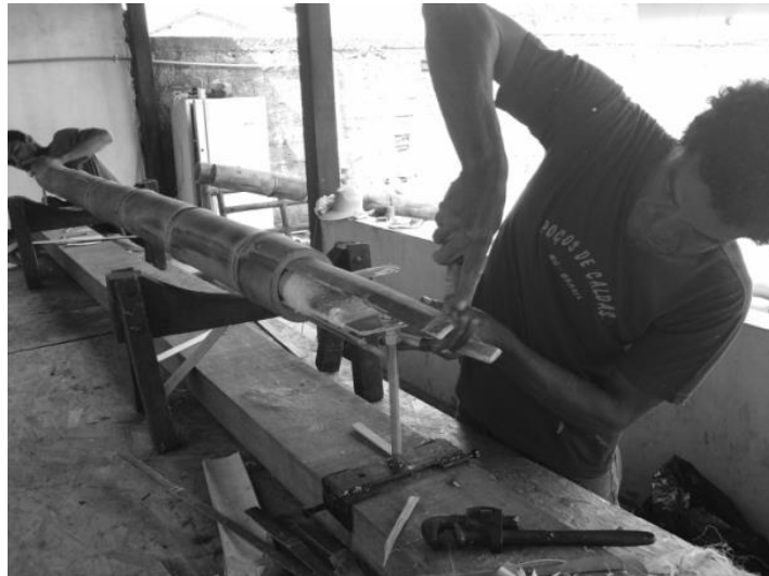
Figura 14: fixação das uniões metálicas com o auxílio de gabarito.
