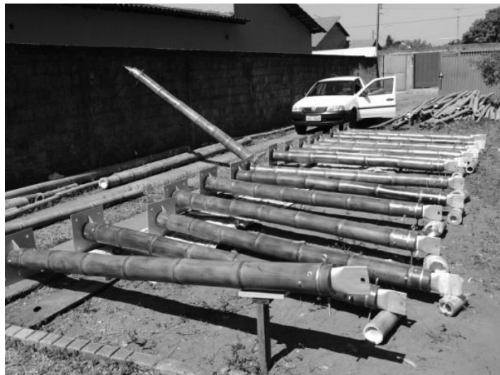
Figura 16: Pilares secando ao sol após aplicação de Stain
