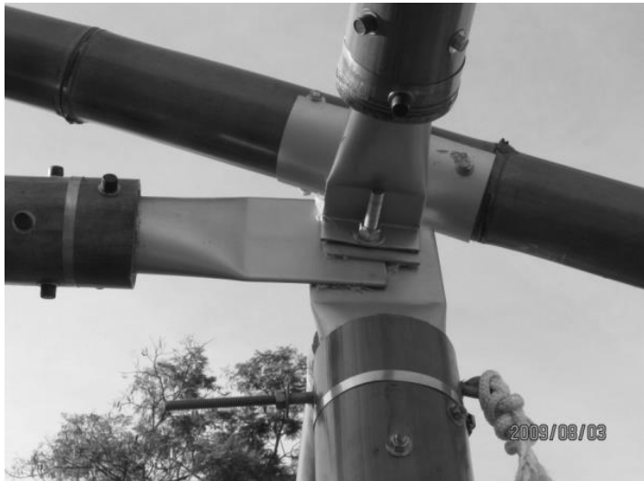
Figura 21: Detalhe das uniões
