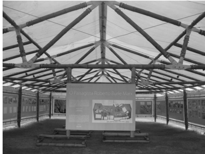
Figura 22: Parte interna da estrutura
