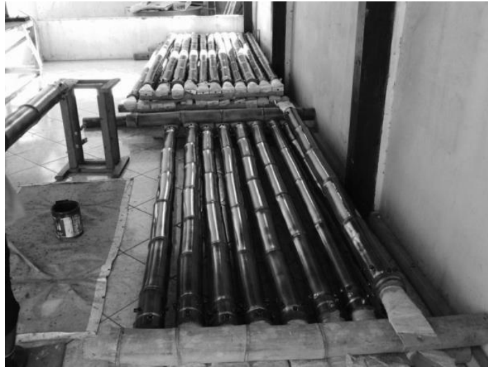
Figura 15: Peças armazenadas para seguir para montagem
