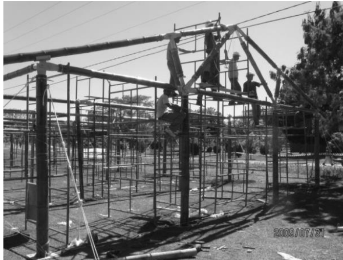
Figura 19: Processo de montagem
