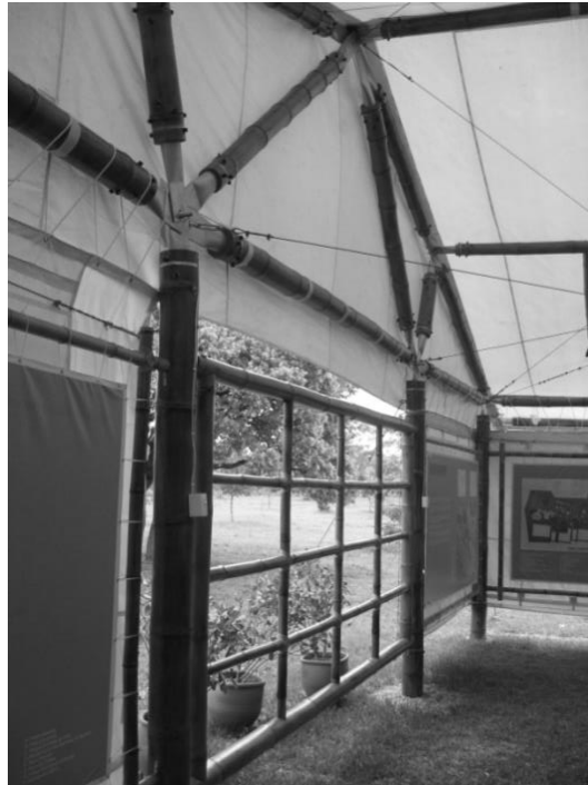
Figura 24: Parte interna da estrutura, vista do pórtico das extremidades.
