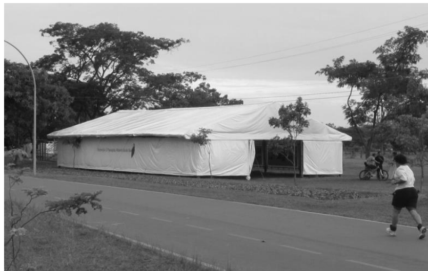
Figura 24: Vista da estrutura coberta.
