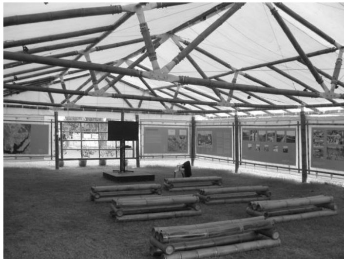
Figura 23: Parte interna da estrutura
