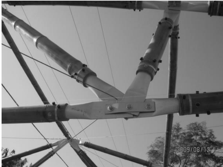
Figura 20: Detalhe das uniões das peças da tesoura
